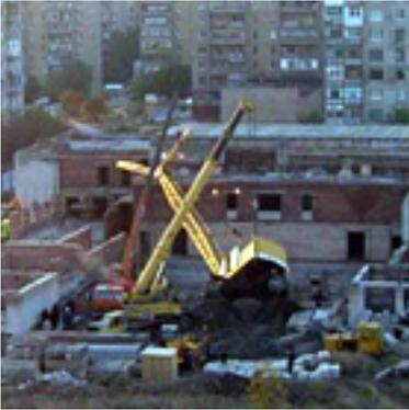
В Горловке на территории стройки школы на 88 квартале произошла аварийная ситуация - опасно наклонился кран. Как сообщил начальник отдела капитального строительства Виталий Ивко, аварийная ситуация произошла по причине высокой влажности земли и, как следствие, ее проседания.
