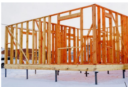
Пример закладки фундамента и строительства стен каркасного дома. Фото: www.vseobz.ru Этапы возведения типового каркасного дома
